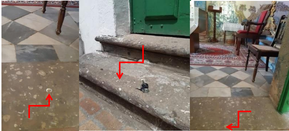
Figura 2 – Detalhes de conchas de marisco na Igreja do parque da Jaqueira, Recife/PE
