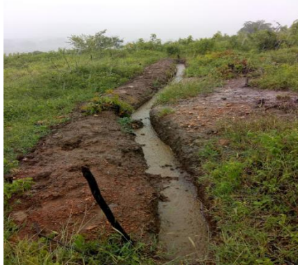
Figura 6 – Terraço de base estreita com água de chuva
